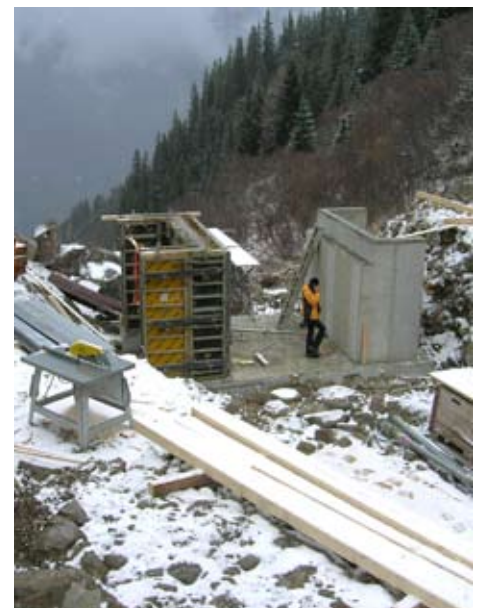
Die Rohbauarbeiten des Pegels Diasbach wurden bereits fertig gestellt.
