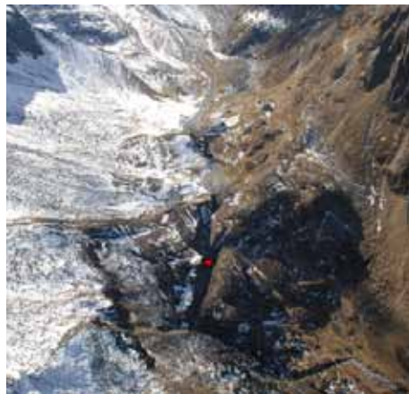
Die Wasserfassung Fernaubach ist ein gutes Beispiel, wie Anlagen möglichst landschaftsschonend geplant werden können.
